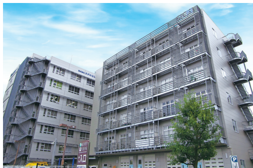
研究所の入るさがみはら産業創造センターの外観
