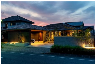
株式会社クラシコ 様 (岩手県) 『目隠し塀を引き立てる明かり』
