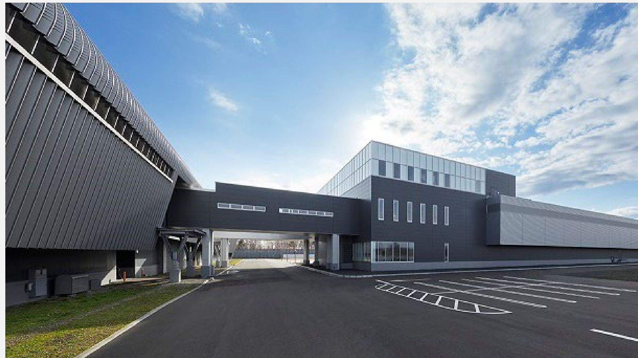
▲石狩データセンター外観（正面：3号棟、左：1・2号棟）
