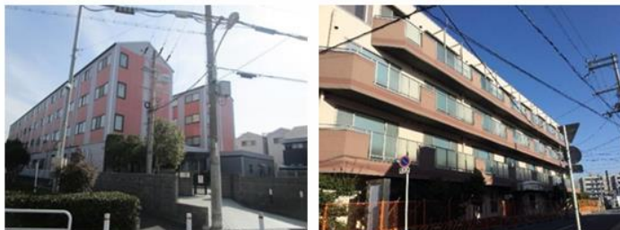
守口市八雲東町の旧社員寮のリノベーション (2025年1月27日竣工)
