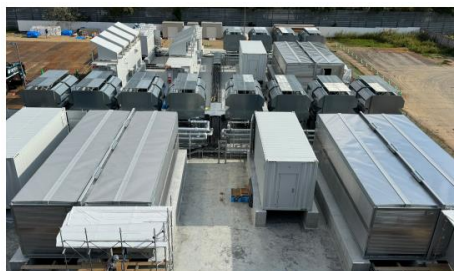
石狩データセンターに構築中のコンテナ型データセンター
