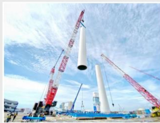
クレーン（洋上風車組み立て）
