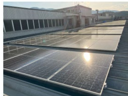
茅野工場 パネル設置状況(24年4月27日)
